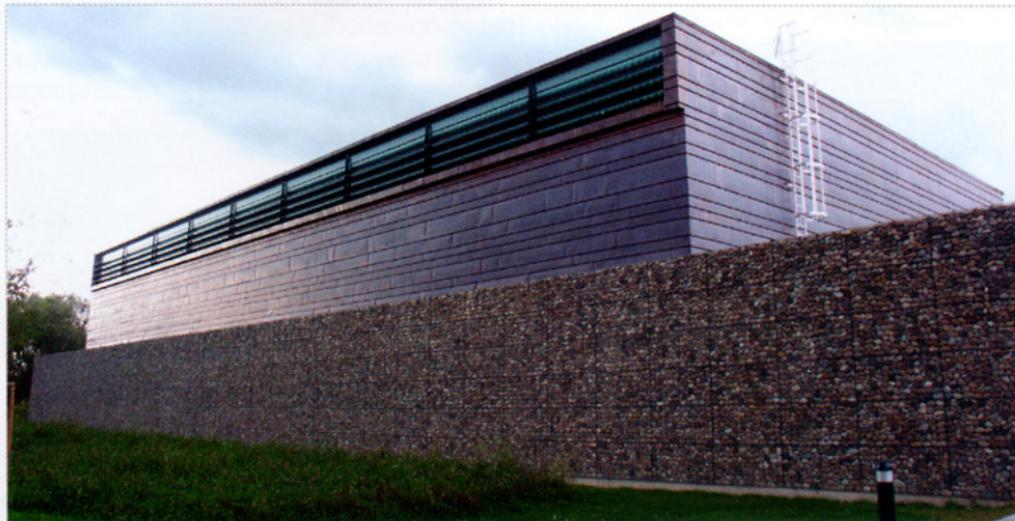
La mise en oeuvre de matériaux naturels, soubassement constitué de gabions d'Aqua Terra Solutions remplis avec des galets du Rhin et bardage et couverture cuivre, y contribue fortement. Les façades sont constituées de bacs cuivre à joint debout, posés horizontalement. Trois largeurs de bandes, mises en œuvre par l'entreprise Couvreur Rhénans, donnent au bâtiment un supplément d'originalité.
