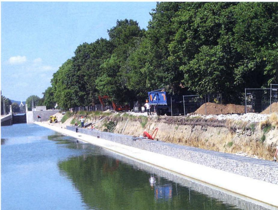
Prévu en boîtes pré-remplies en carrières, le chantier est finalement réalisé par assemblage et remplissage en place de panneaux électrosoudés. Ici, la réalisation du 1er rang d'éléments en cours d'achèvement.
