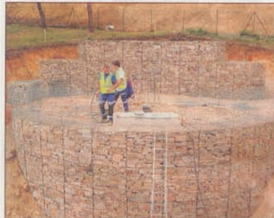
Soutènement en courbe et aménagement paysager en gabions électrosoudés pour l'hôpital du Chandou à Tulle en Corrèze.
