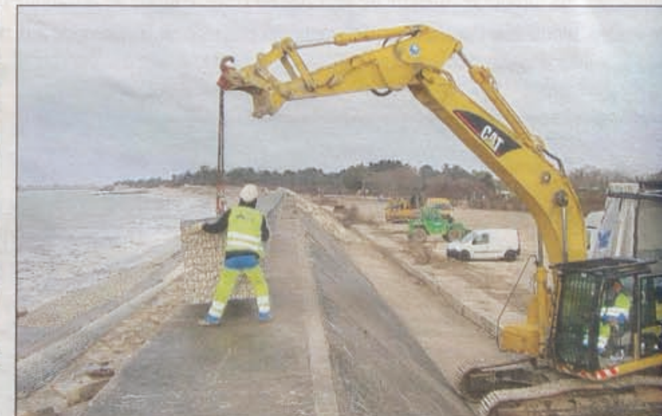
Suite au passage de la tempête Xynthia, 6 semi-remorques de gabions pré-remplis en carrières viennent d'être livrés pour surélever la digue du Boutillon sur l'île de Ré avant la grande marée du 24 mars.
