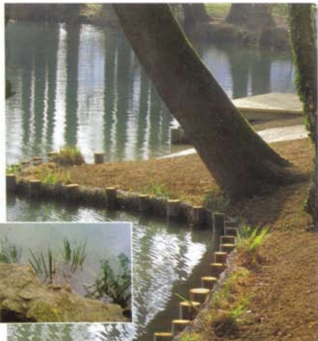
Etat initial de la berge avec muret en pierres (à gauche) et mise en place de boudins de coco pré-végétalisés derrière des pieux et protégés par un grillage en Mars 2009
